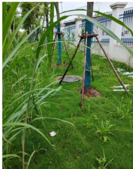
武汉市洪山区建群二桥青菱河西岸上游 210m 城镇雨洪排口-1
