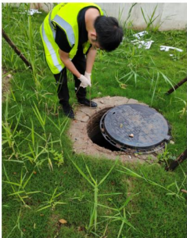
武汉市洪山区建群二桥青菱河西岸上游 210m 城镇雨洪排口-2
