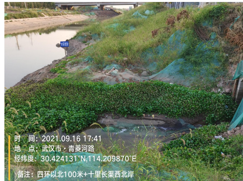
南侧-正在整治的岸坡
