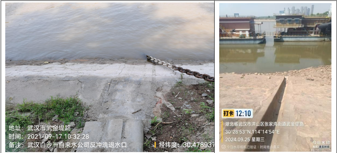
已封堵旧反冲排污口
